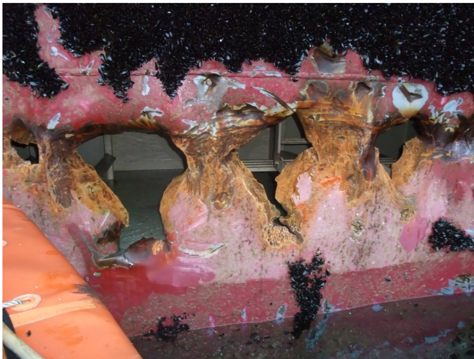
Figur 37: Fem hull i skrogsiden inn i tank nummer 10. Bemerk tydelige merker etter gjentatte slag. Mellom hullene er skroget avstivet på tankens innside, og disse stiverne (avstanden mellom stiverne er ca. 0,6m) har motstått ankerets slag og hindret dypere inntrengning mot tankens indre vegg (1,5 m innenfor). Bildet er tatt i Kristiansund 12. november 2012 av Ptil.
