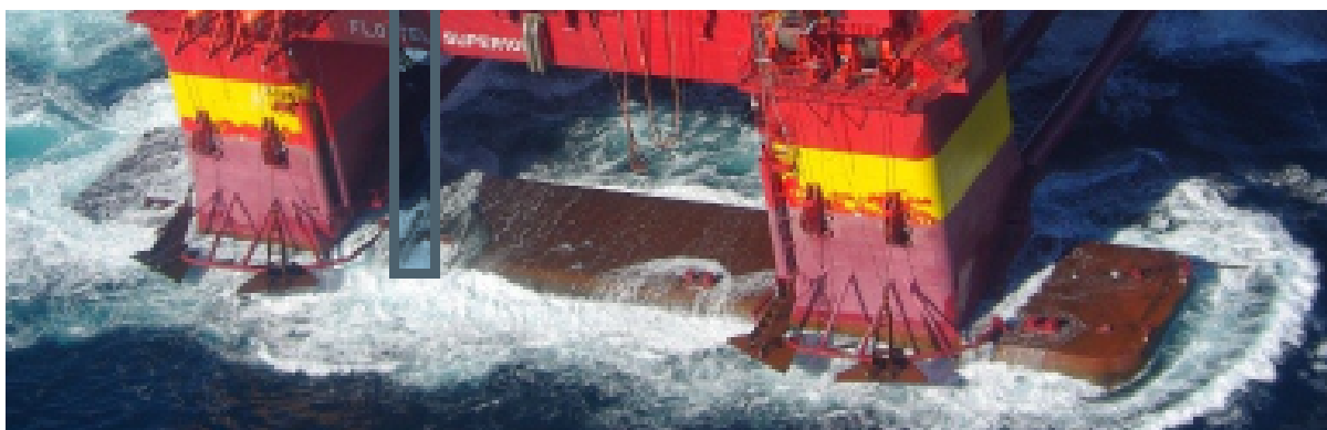
Figur 26: Utsnitt av foto som viser et anker (anker nummer 1 lengst til høyre på bildet) ute av posisjon stående med anker-flya mot nedre skråstag på bolsteret under tauing i transittdyppgang 24. august 2010. Foto: Floatel International [73].
