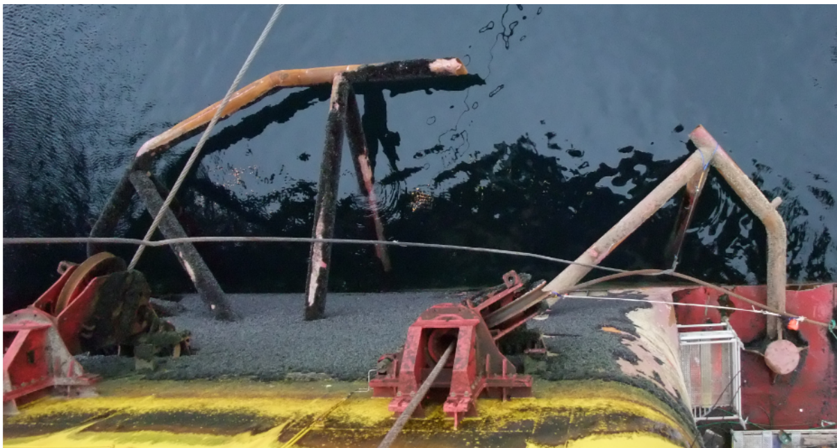
Figur 12: Bolsteret etter skaden. Line 7 til venstre og 8 til høyre. Line 7 er her brukt til fortøyning til land. Linen som går på tvers over bildet er pennantwiren. Ved å sammenlikne med Figur 11 kan en se hvilke deler som er falt av. Bildet er tatt i Kristiansund 13. november 2012 av Ptil.
