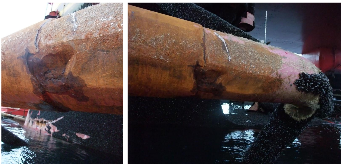
Figur 30: Sliteskader hvor anker nummer 7 har stått feilplassert i bolsteret (mot akter-enden av Floatel Superior) og slitt bolstermaterialet og sliteflaten ved kanten av sliteflaten (til venstre). Merk også flaten som er skrappt plan på bolster-grunnmaterialet til høyre. Disse observasjonene tolkes som at anker nummer 7 (og øvrige ankre på tilsvarende vis) i lange perioder har beveget seg utenfor den dedikerte plassen i bolsteret (på sliteflaten). I tillegg betraktes lokal-slitasjen på kanten til sliteflaten som at ankeret har stått «låst» i denne posisjonen og at store kontakttrykk har medført omfattende lokal slitasje. Ved bevegelser av ankeret fra sliteplattens midtposisjon er geometrien av bolstrene slik at wirelengden økes. Denne utformingen har hatt som formål å sentrere ankrene ved plassering i bolstrene, men på grunn av at
