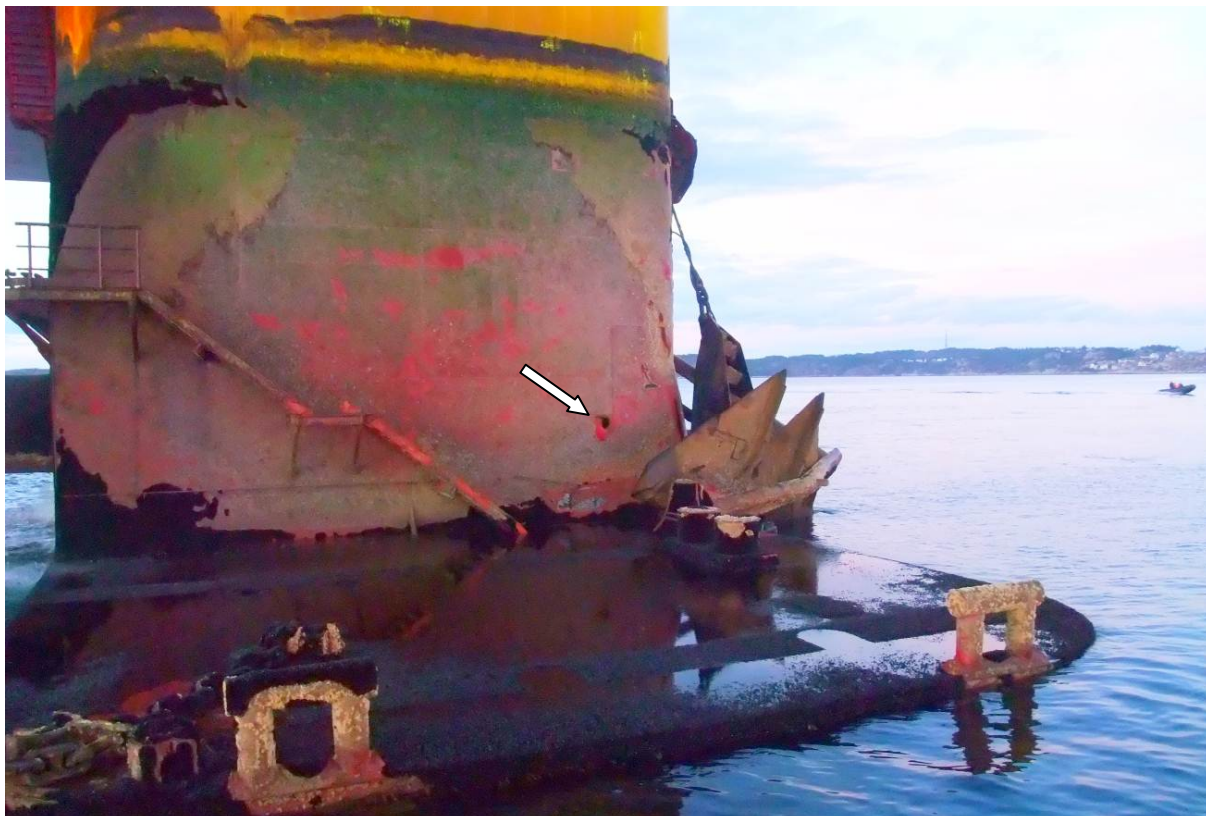
Figur 40: Fremre babord søyle ved ankomsten til Kristiansund den 10. november 2012. Anker nummer 8 ligger fast i bolsteret og hullet inn i tank nummer 10 ses tydelig (markert med pil). Noen skrapemerker nederst på søylen viser at ankeret har beveget seg i området. Pennantwiren som er tvinnet rundt ankerwiren (over ankeret) viser at ankeret har rottert. Bildet er tatt av Petroleumstilsynet.
