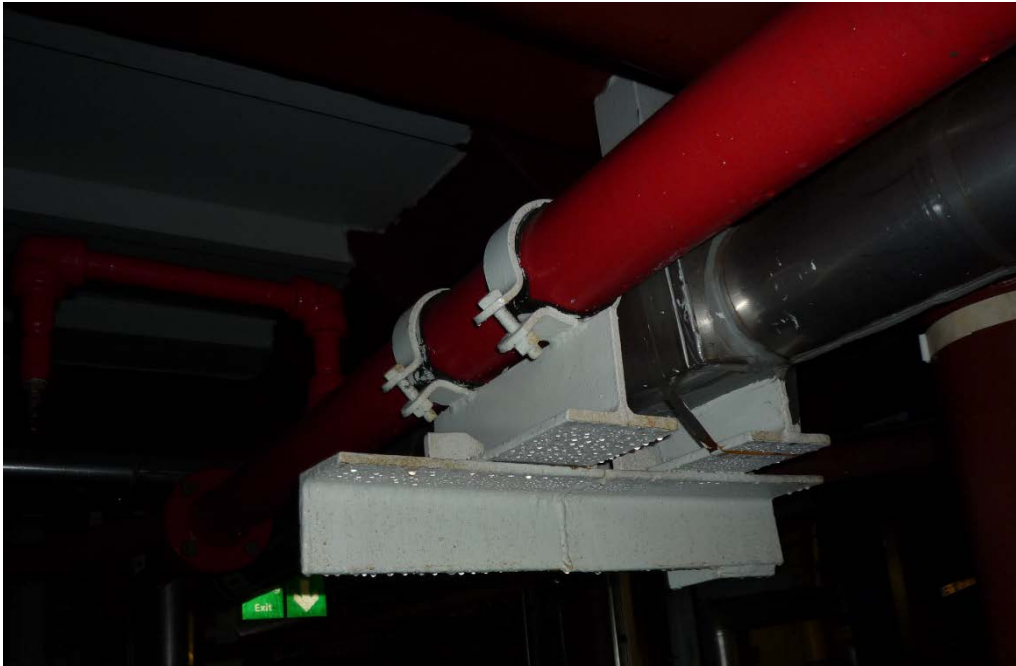
Figur 5 Ansamling av fuktighet på utsatte steder
