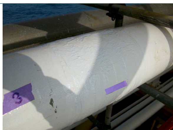
Etter påføring av toppstrøk
