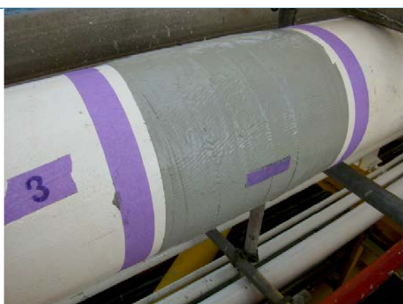
Etter legging av komposittreparasjon
